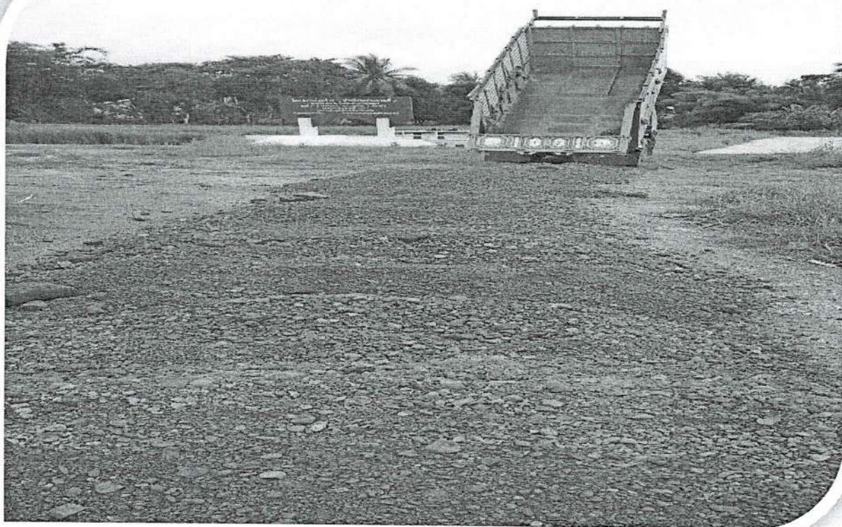
โครงการก่อสร้างและซ่อมแซมถนนลูกรัง ม.3,4,7,11
