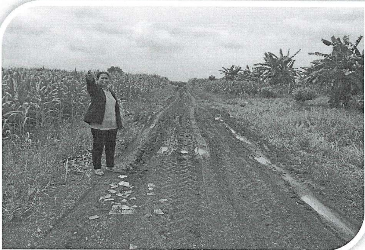
ปรับปรุงถนนที่น้ำท่วมขัง(ชุดร่องน้ำ,วางท่อ,ลงดินลูกรัง) ม.13
